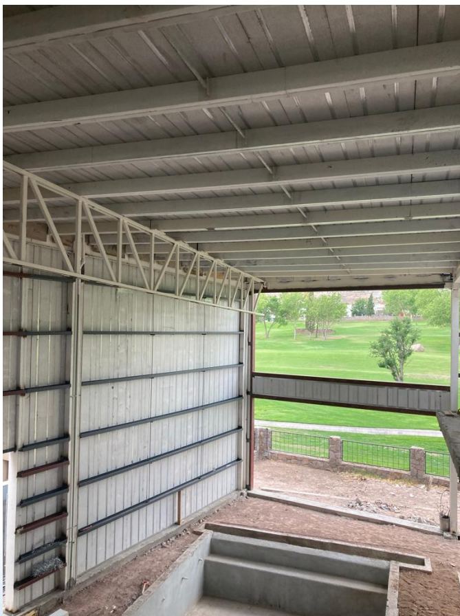
IKOS EN TECHUMBRE Y FACHADA
